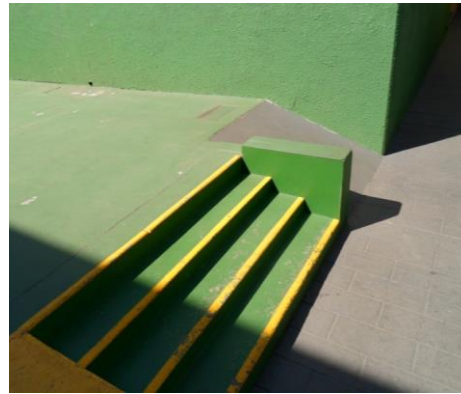
Foto 5: rampa da unidade da av.16 - pelo autor (08/2013)
