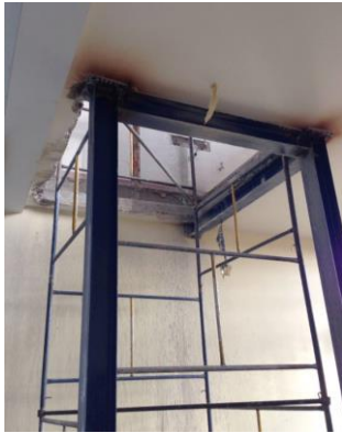
Foto 4: caixa do elevador na unidade da Av.16 - site: www.facebook.com/ColegioKoelle ;
