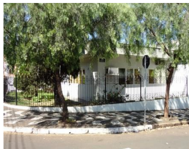
Figura 11 - Janelas de uma edificação em Araras, que proporcionam ventilação cruzada.
