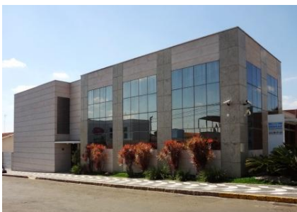
Figura 6 - Fachada com pele de vidro.
