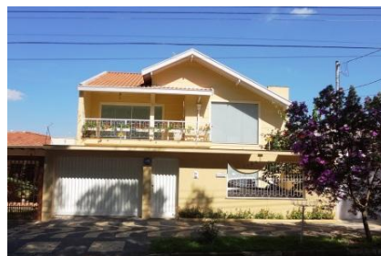
Figura 7 - Fachada com grande janela envidraçada, e varanda com proteção.
